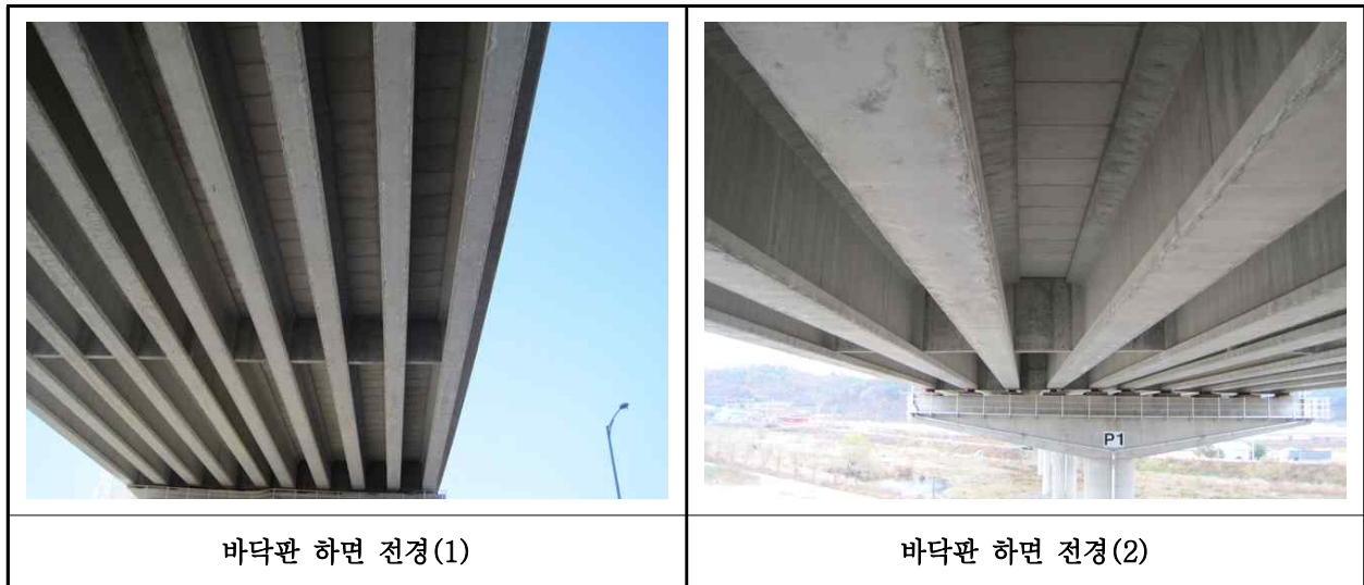
【사진 33.3.2】바닥판하면 전경
