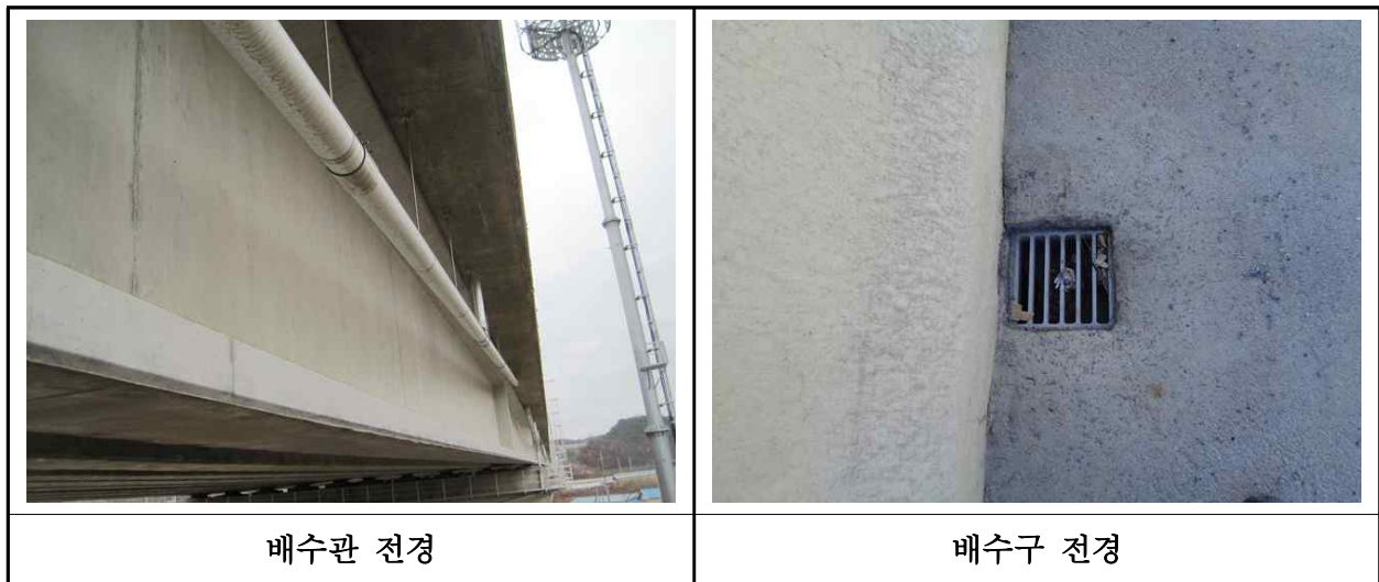
【사진 33.3.43】 배수시설 전경
