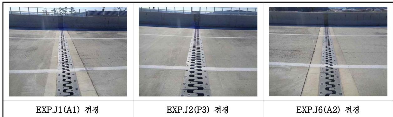
【사진 33.3.16】 신축이음장치 전경
