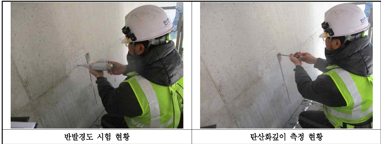
【사진 33.4.1】 콘크리트 내구성조사 현황
