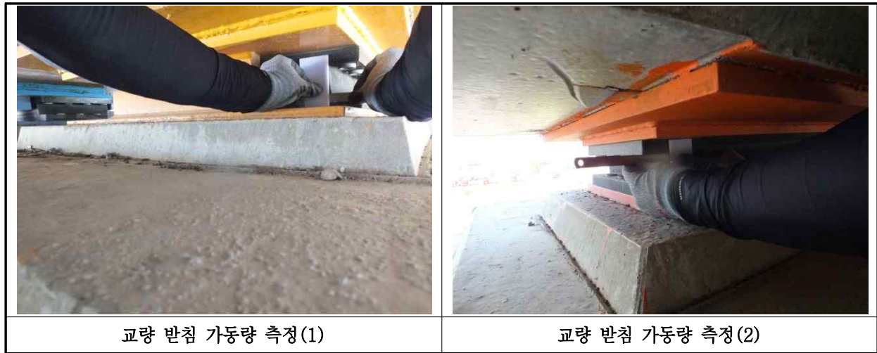
【사진 33.3.15】 교량받침 이동량 측정
