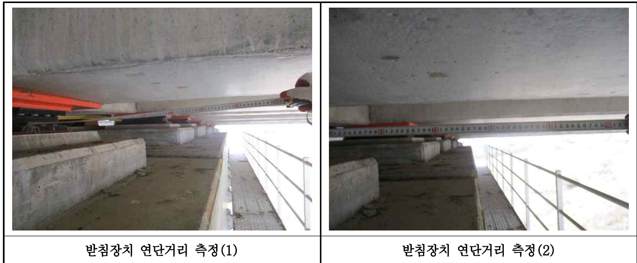
【사진 33.3.36】 교량받침장치 연단거리측정
