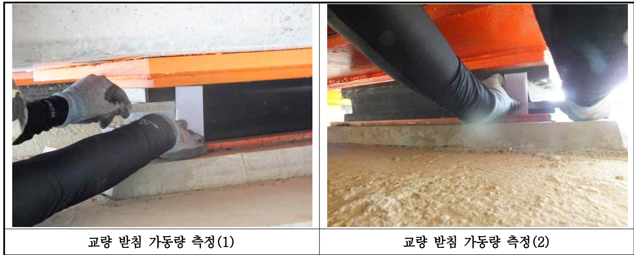
【사진 33.3.37】 교량받침 이동량 측정
