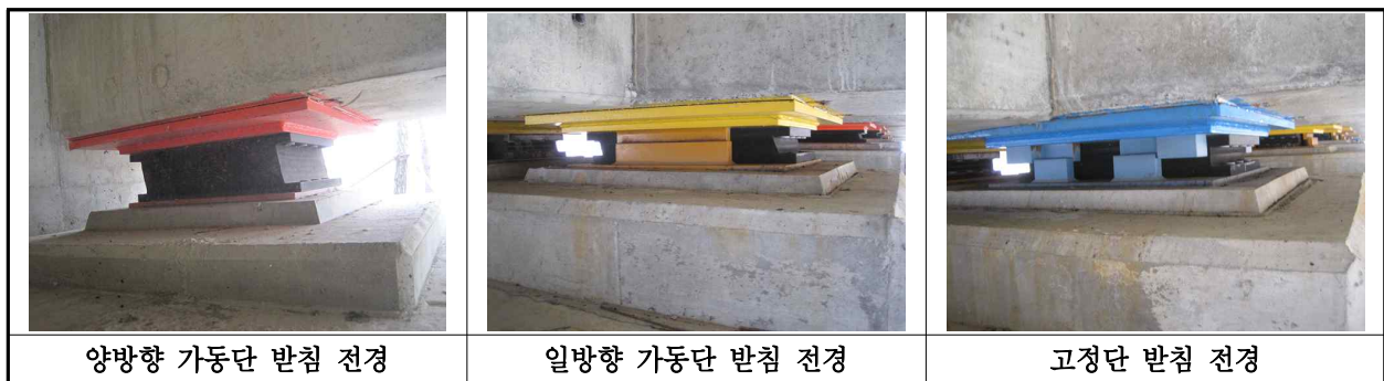
【사진 33.3.12】 교량받침 전경
