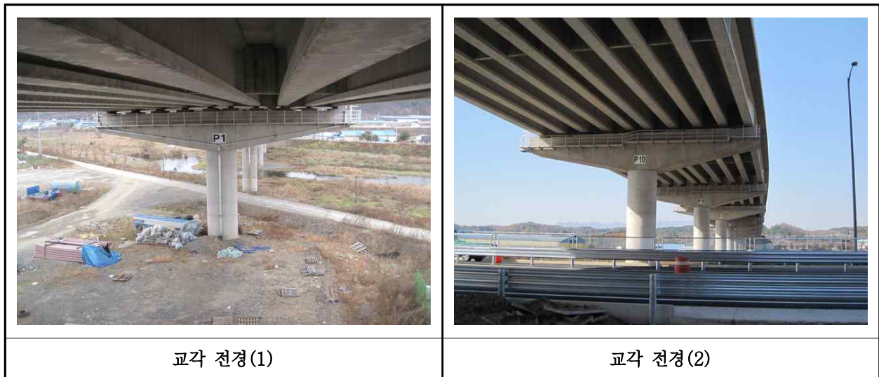
【사진 33.3.10】 교각 전경
