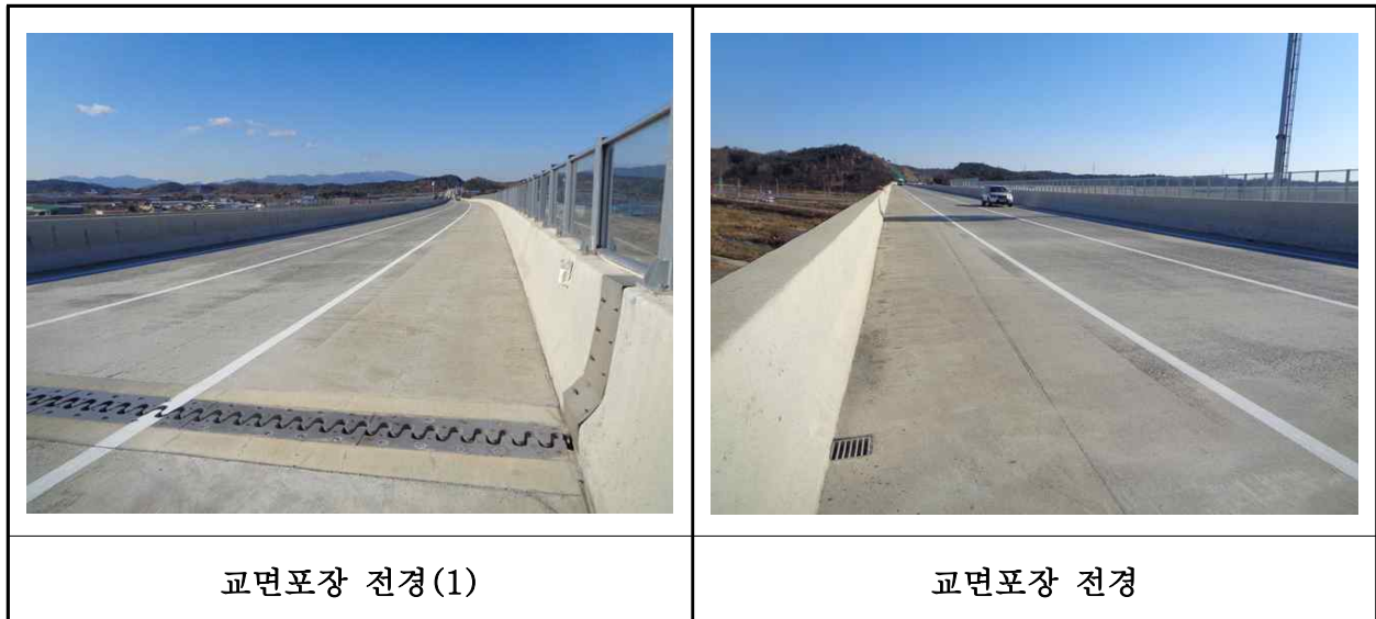
【사진 33.3.19】 교면포장 전경
