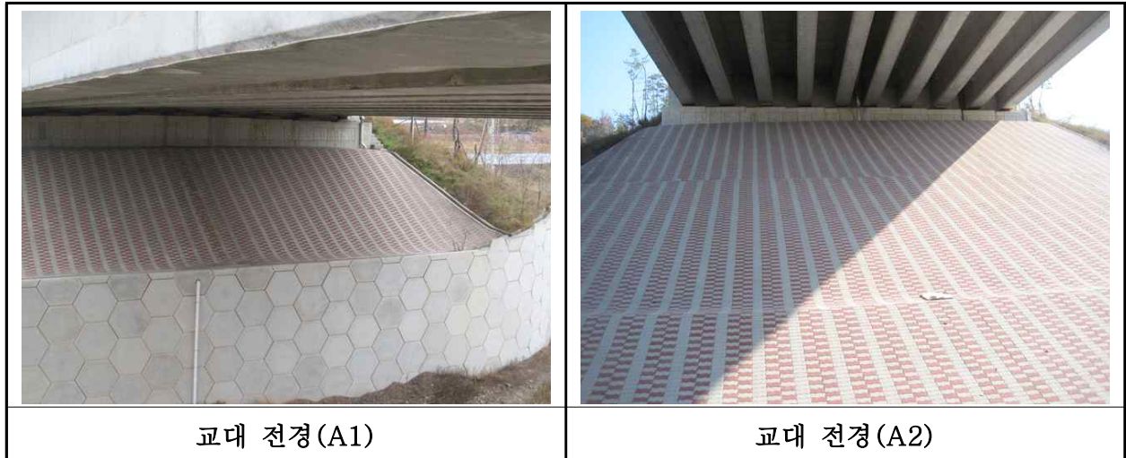
【사진 33.3.8】 교대 전경
