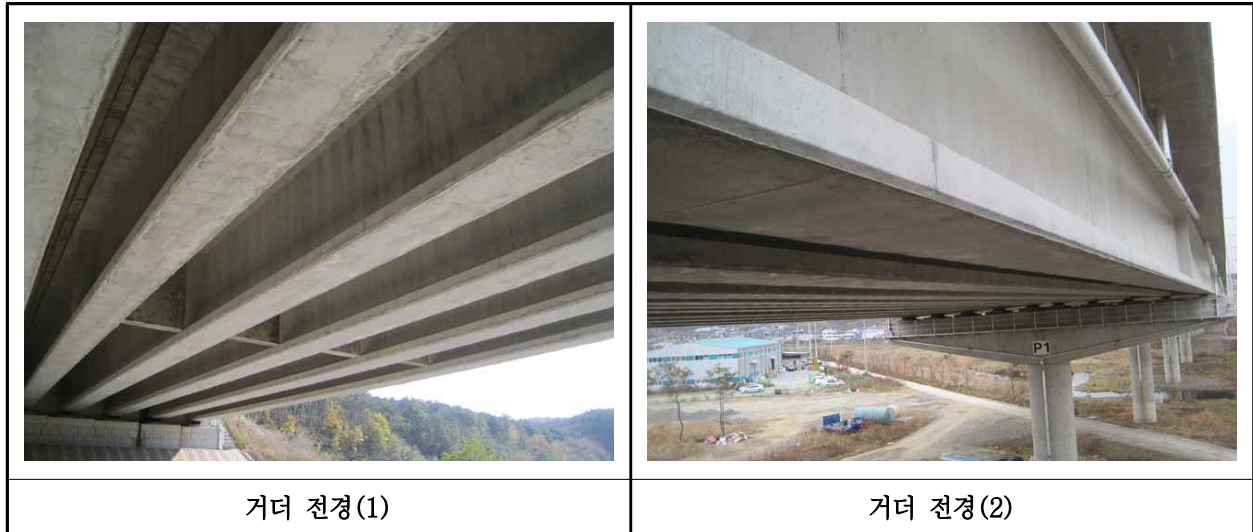
【사진 33.3.27】 거더 전경
