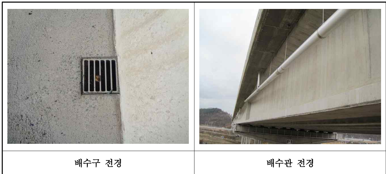
【사진 33.3.21】 배수시설 전경
