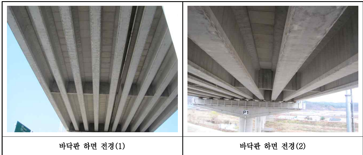
【사진 33.3.25】 바닥판하면 전경
