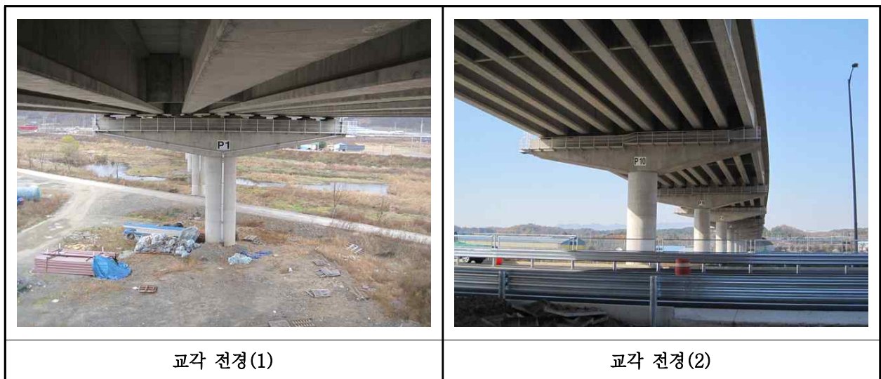
【사진 33.3.33】 교각 전경
