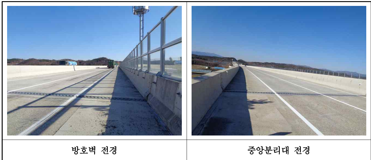
【사진 33.3.45】 방호벽 및 중앙분리대 전경
