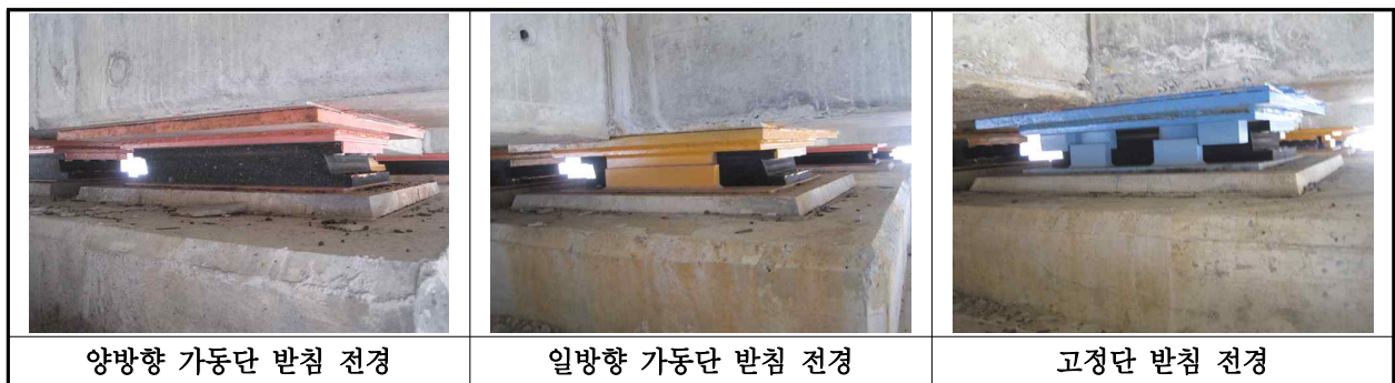
【사진 33.3.4】 교량받침 전경
