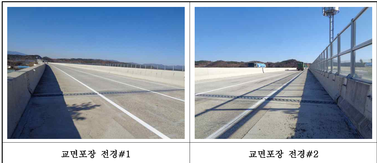
【사진 33.3.41】 교면포장 전경
