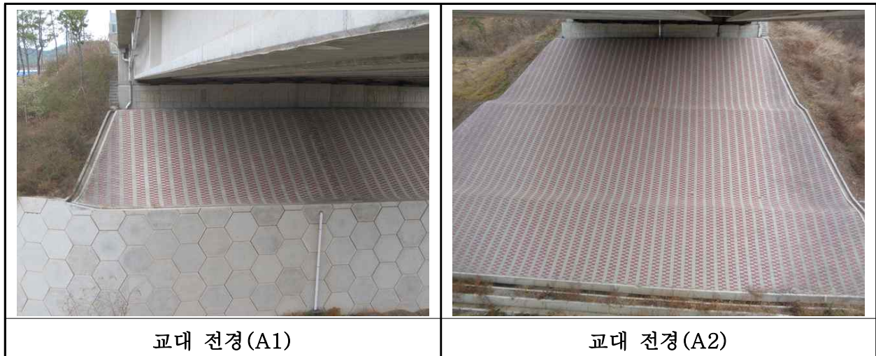
【사진 33.3.31】 교대 전경
