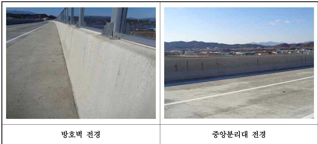
【사진 33.3.23】 방호벽 및 중앙분리대 전경
