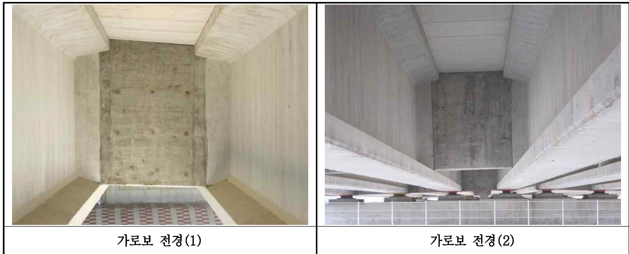
【사진 33.3.6】 가로보 전경
