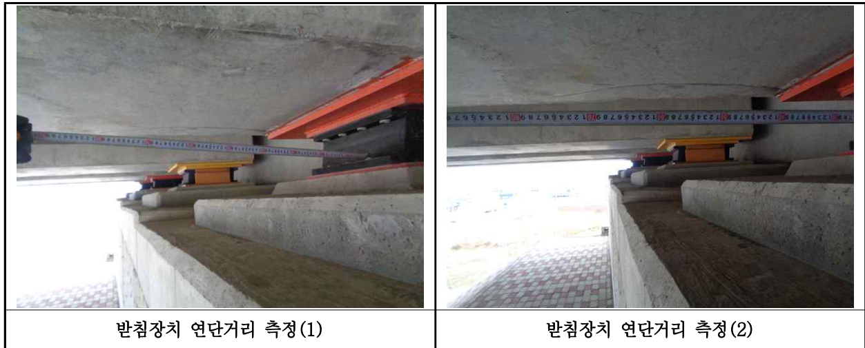
【사진 33.3.14】 교량받침장치 연단거리측정
